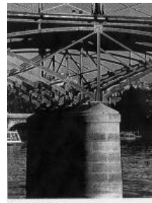
Figures 10 & 11 : exemples du Pont Firth of Forth en Ecosse en 1889 et du pont cantilever en acier et l'exemple du Pont des Arts à Paris en 1802 en fonte)
